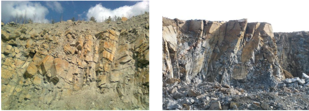
Рис. 1. Фото діючих вибоїв гранітних кар'єрів Житомирщини з видимими характерними системами тріщин (ВАТ «Березівський кар'єр», ВАТ «Бехівський гранкар'єр»)
