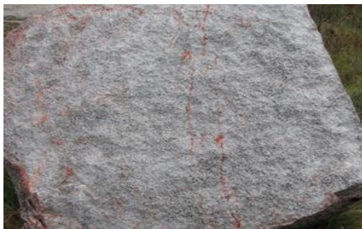
Рис. 1. Зображення блока природного каменю з виявленими тріщинами за допомогою кольорової дефектоскопії
